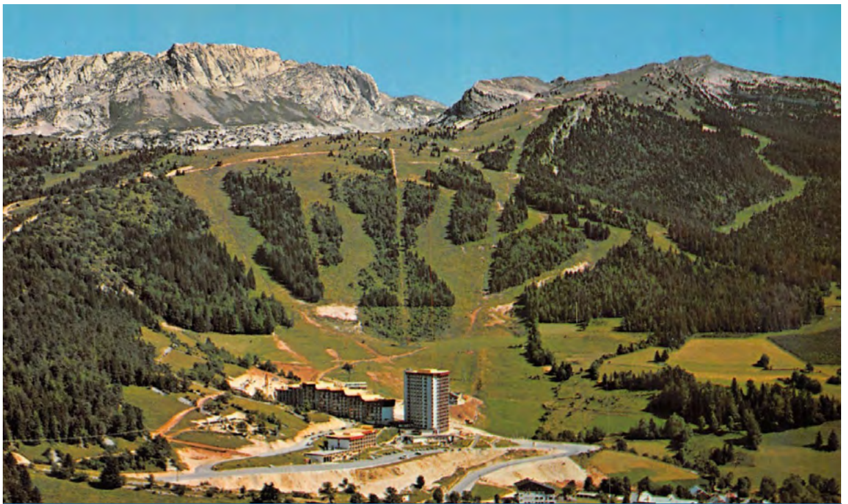
Entre 1951 et 1971, la station de Villard-de-Lans se développe en installant des téléskis d'abord sur la zone de Côte 2000, puis aux Glovettes. En 1975, la municipalité donne à la SEVL l'autorisation d'étendre la concession du domaine skiable sur la Grande Moucherolle.
